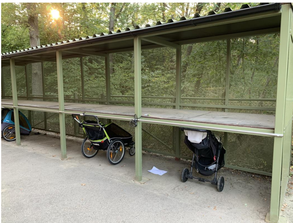
Figur 5-2 Exempel på väderskyddad parkering för barn- och cykelvagnar utformad i två våningar för ökad yteffektivitet. Här kan även parkerade fordon låsas fast vid den längsgående metallstång mellan våning ett och två vilket möjliggör stölsäkert förvaring under längre tid.
