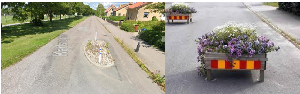
Figur 5-6 Exempel på utformning av lokal avsmalning som kan anläggas på aktuell plats längs Gläntvägen som inte påverkar cykeltrafik. Avsmalningen kan antingen vara fast (bild till vänster) eller mobil (bild till höger).
